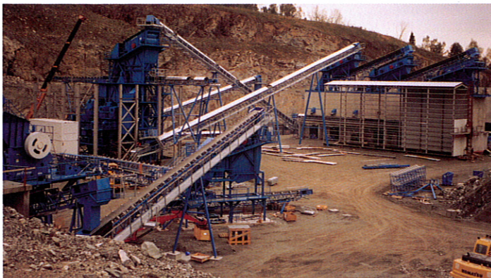
Krossanläggning åt Franzefoss Pukk AS i Norge är Stål & Rörmontages största enskilda uppdrag någonsin.
