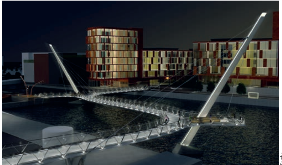
Bild 4. Ljussättningen av brobanan sker från punktbelysning i handledarna, men effektbelysning ska installeras både vid foten och i toppen av respektive pylon. Dessutom finns slitsar i pylonens alla hörn, i vilka längsgående ljuslister kommer att placeras och på toppen av pylonerna står akrylkupoler som ska lysas upp av två armaturer från insidan.
